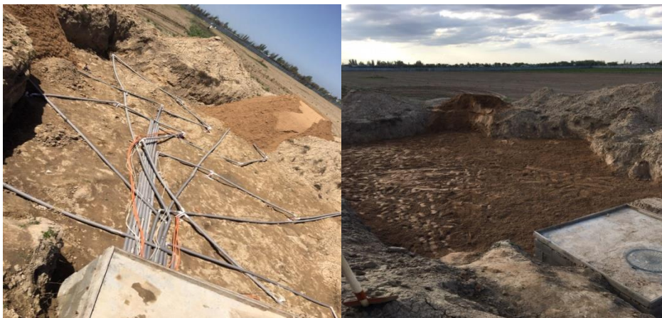
2.3 – сурет – Жер асты жылу сақтау ұңғымалары
